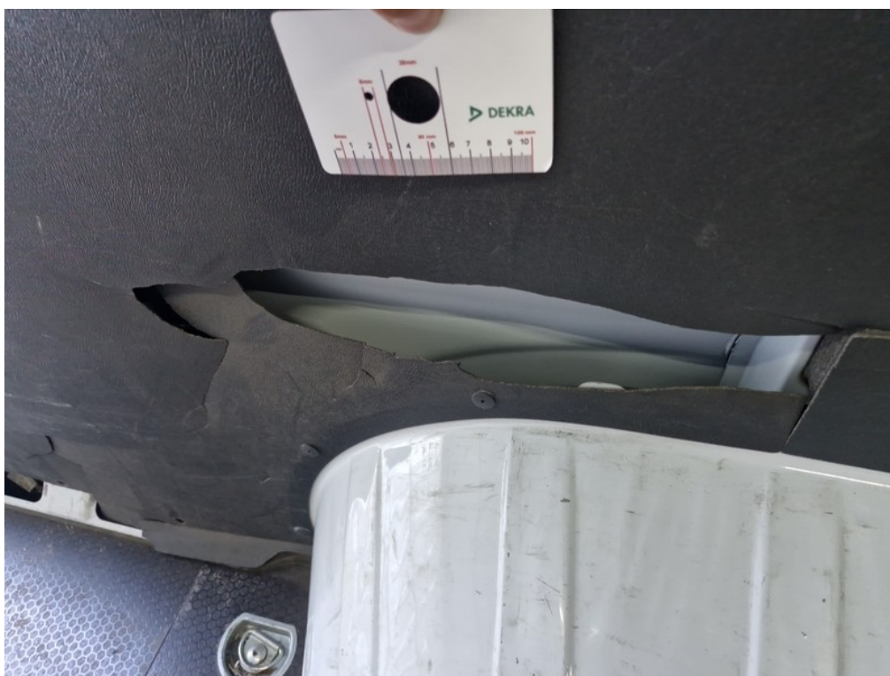
Vid' popis k poškodeniu č. 19
