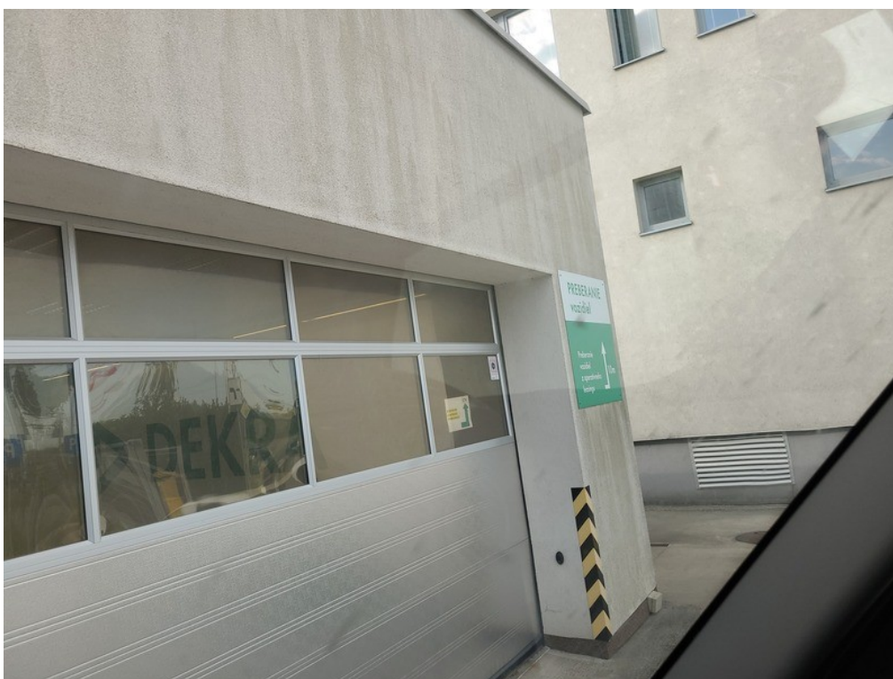
Vid' popis k poškodeniu č. 10
