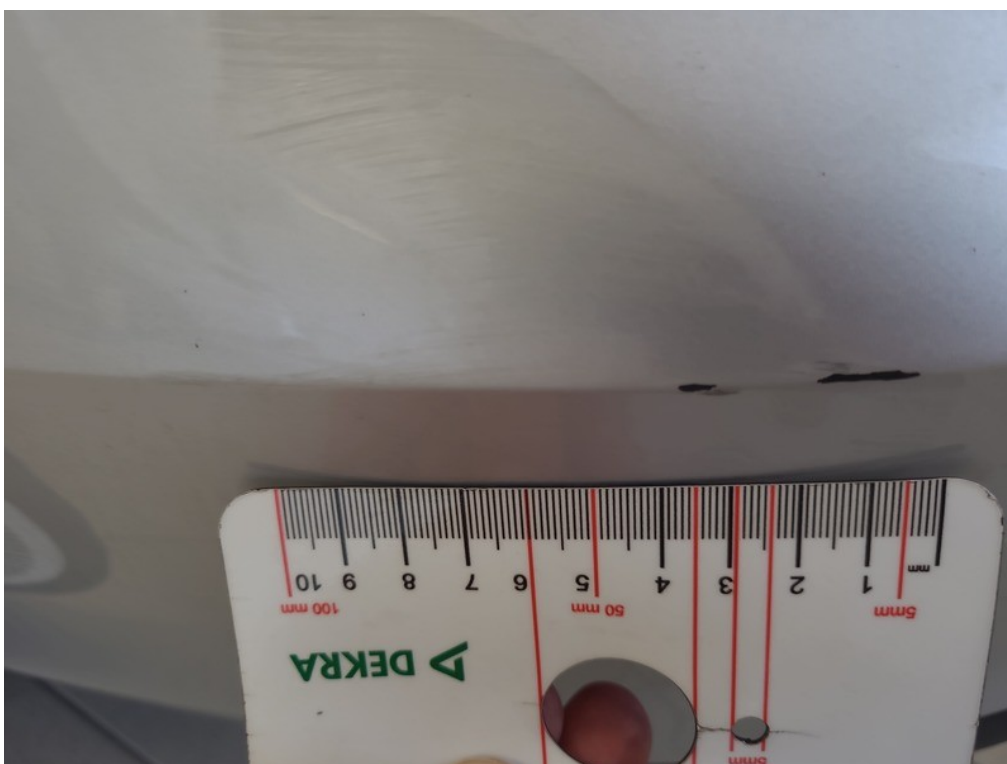
Vid' popis k poškodeniu č. 10
